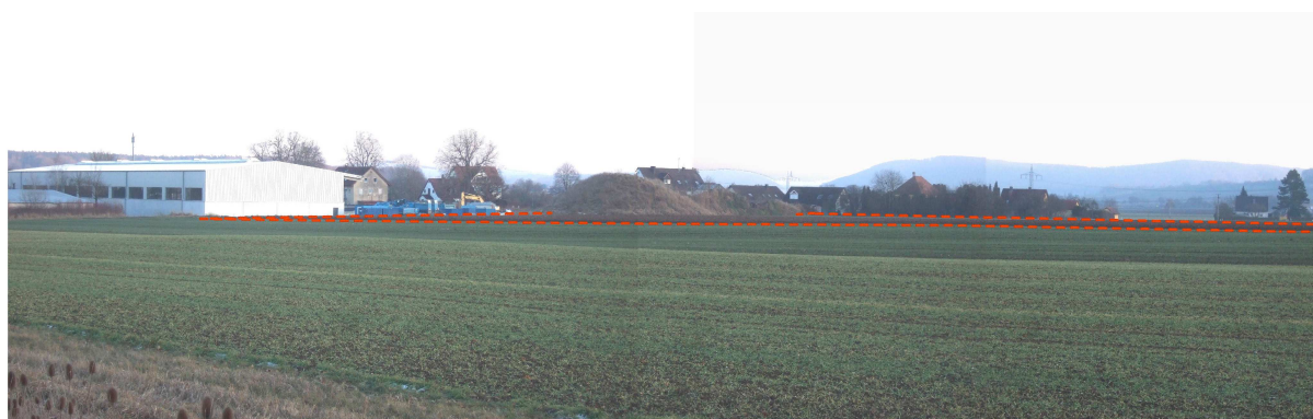
Foto: Blick aus nordwestlicher Richtung zum Planungsgebiet. Die Lage des geplanten Geltungsbereichs ist mit einer roten Linie markiert.
